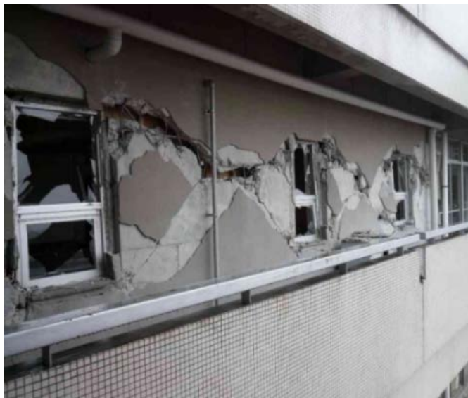
庁舎の被害（東日本大震災）
