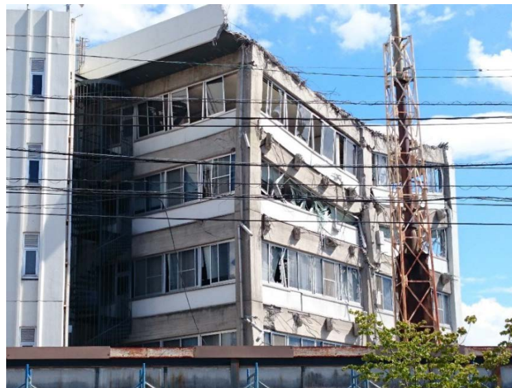
庁舎の被害(熊本地震)
