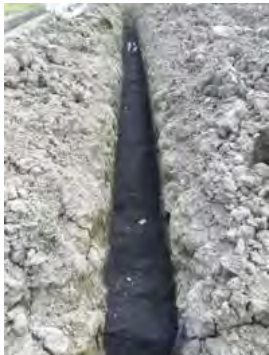
埋設前のもみ殻炭暗渠
