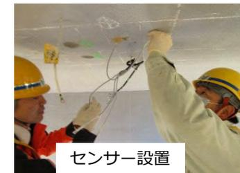
再アルカリ化施工後の追跡調査にpHおよび塩分センサーを利用 (H30年1月～)。
