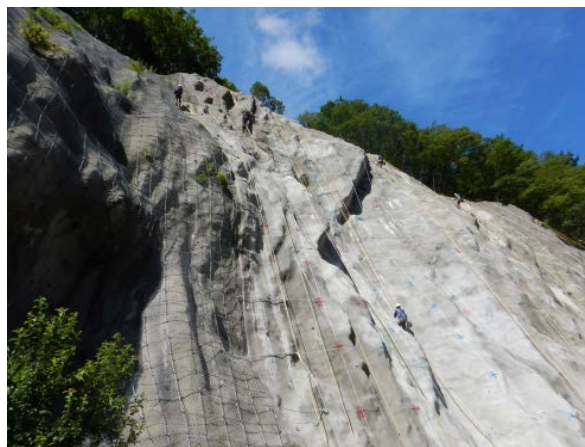
図-2 モルタル吹付工
