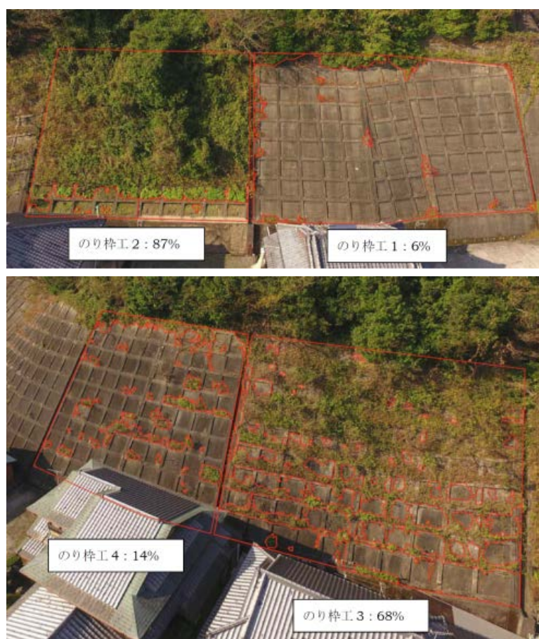
図-3 施設の植被率調査の例 (のり枠工2のみ枠内吹付が無い)
