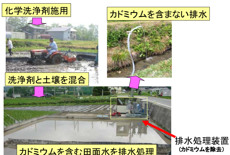
図1 カドミウム汚染土壌の化学的洗浄法
