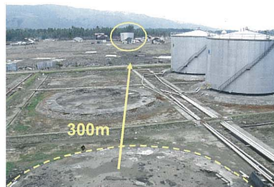
写真2 流出したオイルタンク
