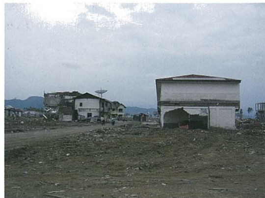
写真1 Banda Aceh における津波被害
