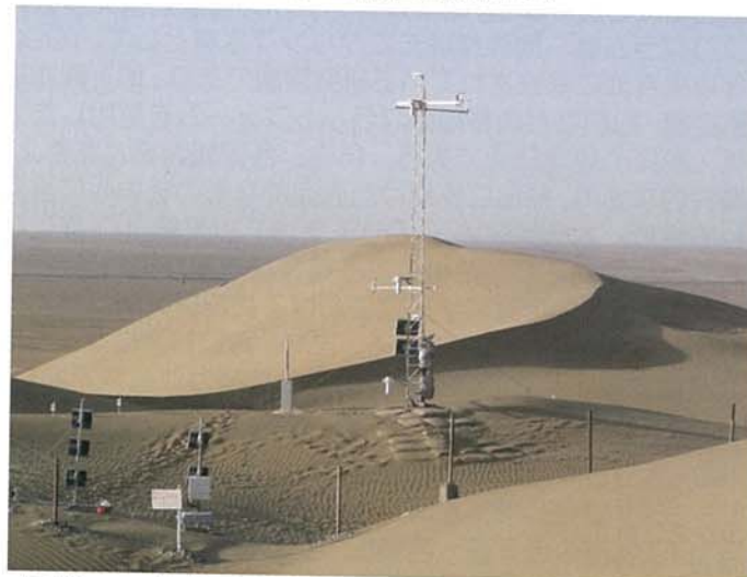
写真1 策勒（チーラ）に設置した地上気象自動観測装置（AWS）
